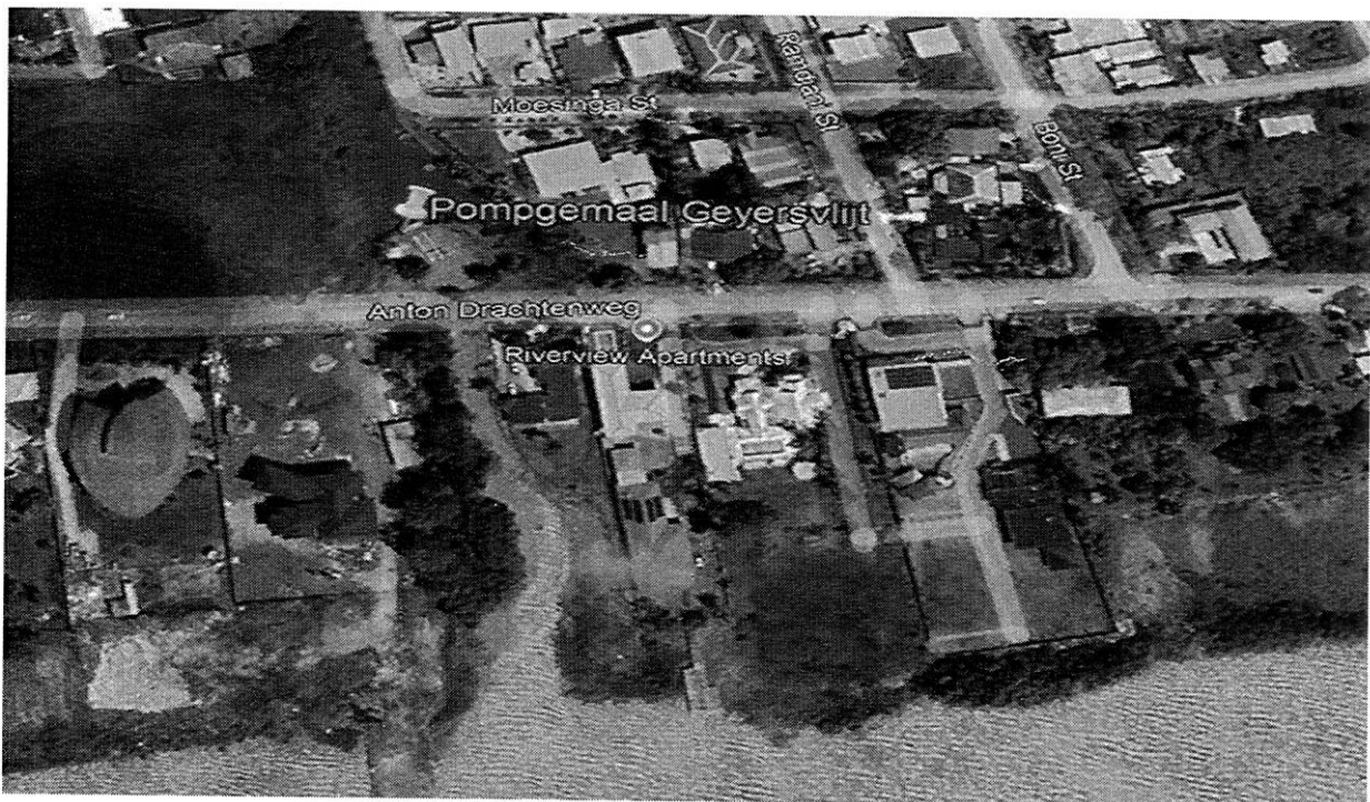
Figuur 20c: Location foto van pompgemaal Geyersvliet
