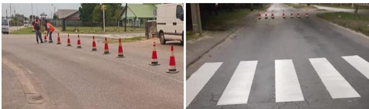
Figuur 95:9 Aanvang WA met de uitvoering van onderhoudswerkzaamheden aangaande het aanbrengen van thermoplastische wegmarkeringen op primaire wegen binnen Paramaribo 2024.
