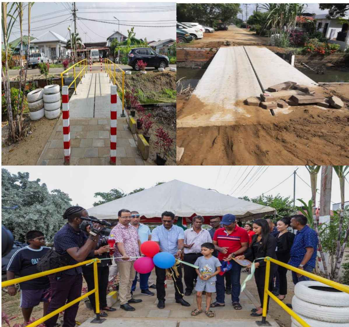
Figuur 18: Oplevering 3-tal betonnen loopbruggen over het Toevluchtkanaal in de Vioolstraat.
