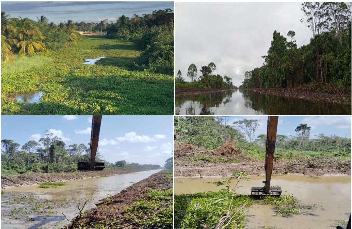
Figuur 20: Saramacca kanaal opschoningswerkzaamheden 2024.
