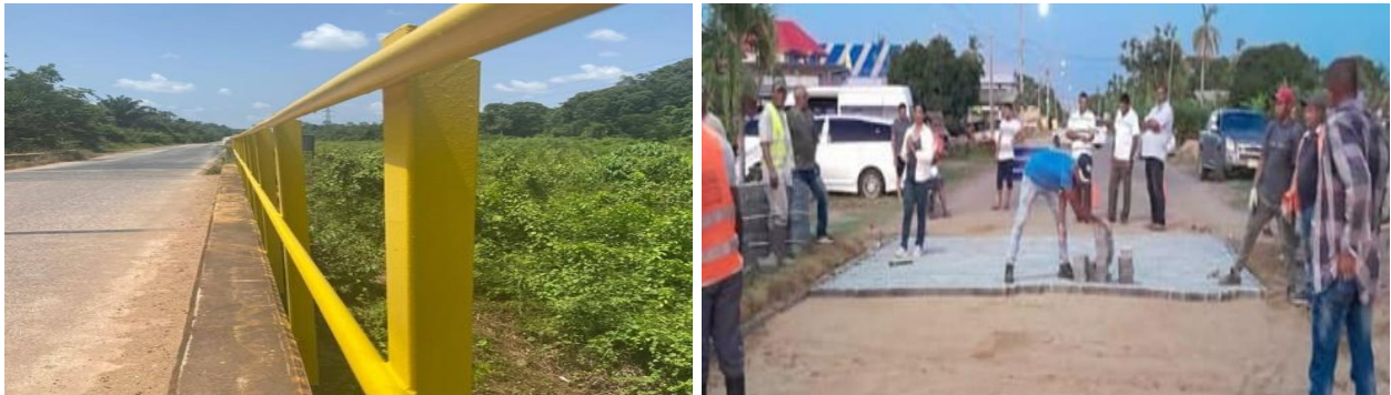
Figuur 89: Herstelwerkzaamheden brug Marshall kreek WA & spoedherstelwerkzaamheden uitgevoerd op de Ir. M. N. Ataoellahweg in het district Nickerie in samenwerking met het Ministerie van Openbare Werken.
