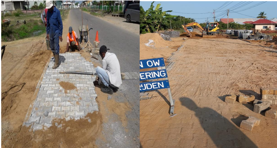
Figuur 71: Het herstellen van wegverzakkingen.
