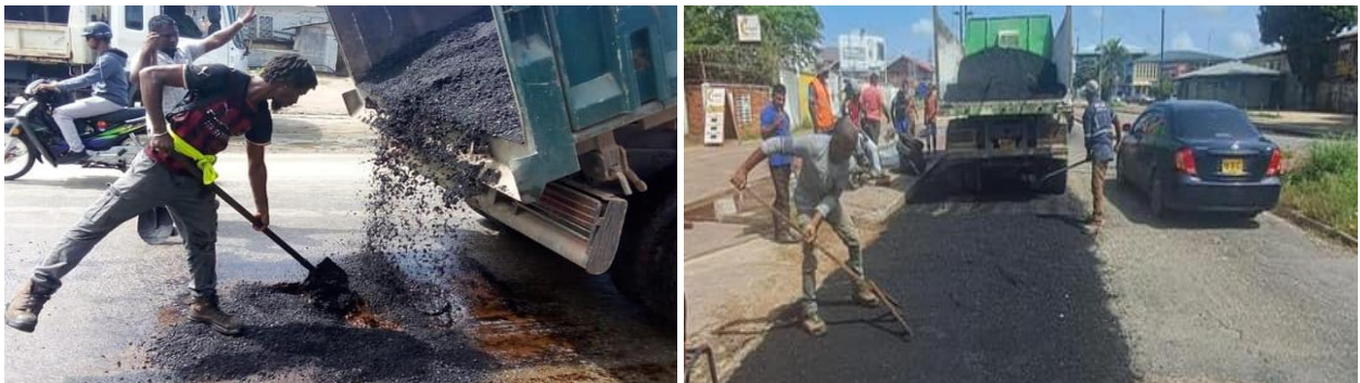
Figuur 90: Kleine weg reparaties WA ism Min OW wegen, Van Idsingastraat, Jaggernath Lachmonstraat, Willem Campagnestraat, Van 't Hogerhuysstraat, Veldhuizenlaan, Kwattaweg, Kankantriestraat & Hernhutterstraat.
