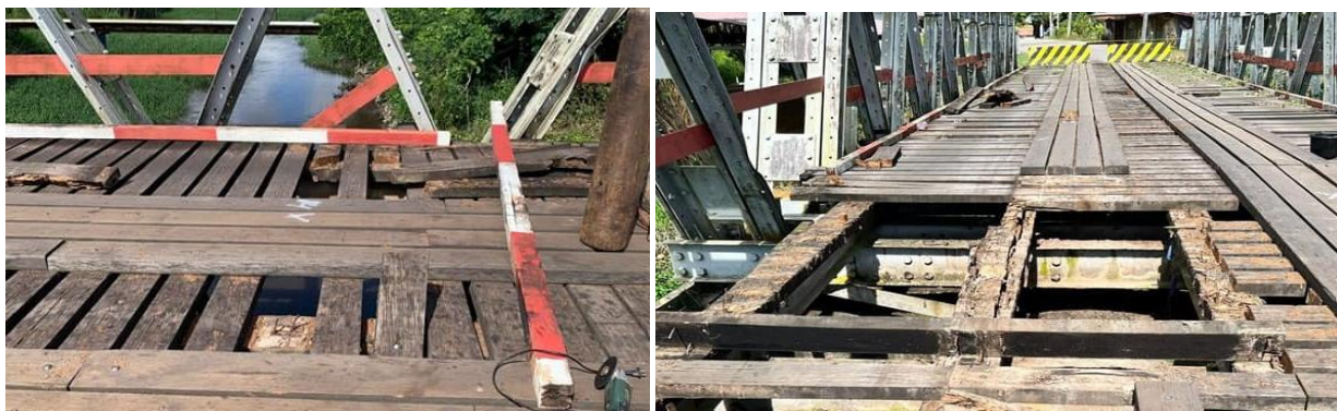
Figuur 96:10 Reparatie brug over de Para rivier Sir Winstonchurchillweg.
