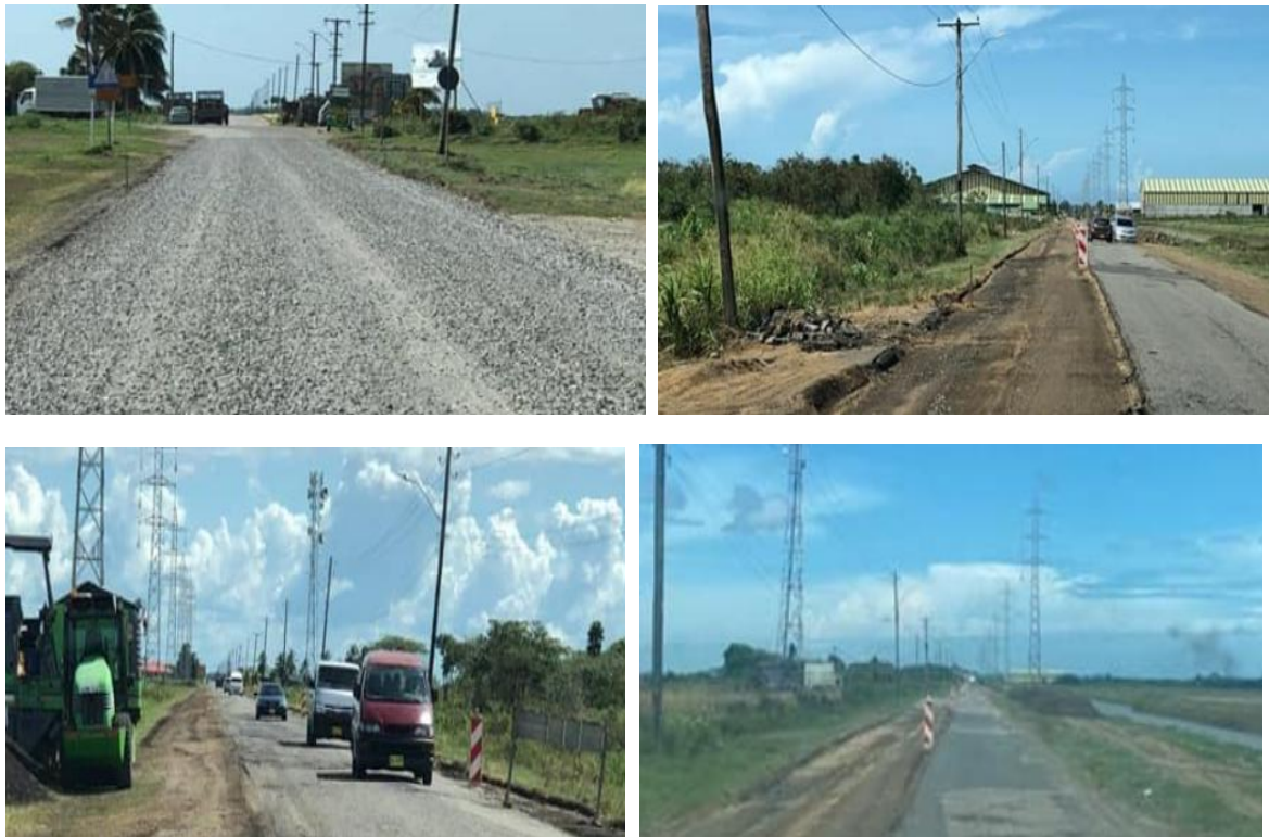
Figuur 83: Overzicht asfaltering en reparatiewerkzaamheden te Nickerie 2024.
