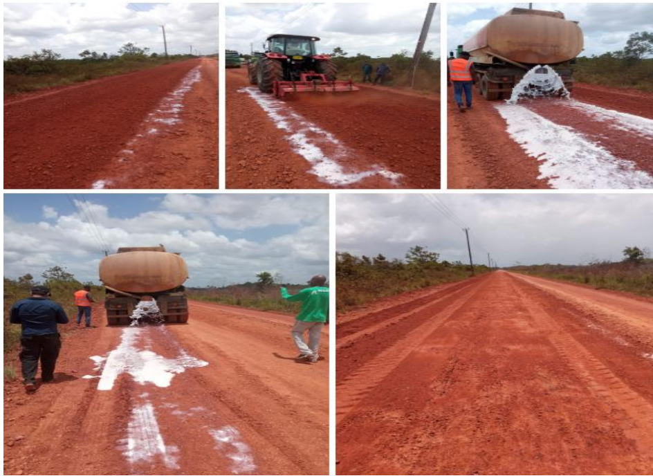
Figuur 62: Pilotproject gestart voor het aanbrengen en verwerken van de verhardingsapplicatie, egaliseren van de weg.
