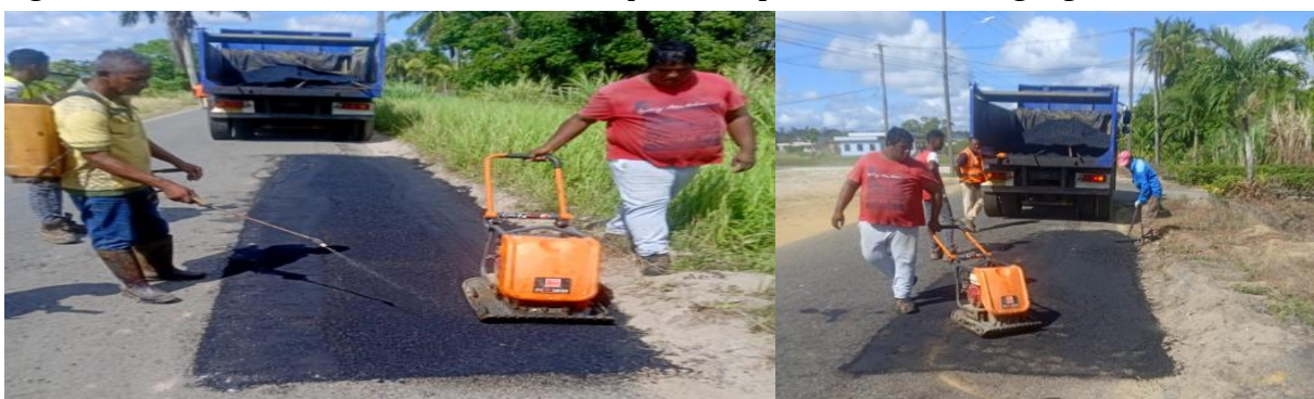
Figuur 15: Dichten van potholes met warm asfalt 2024.
