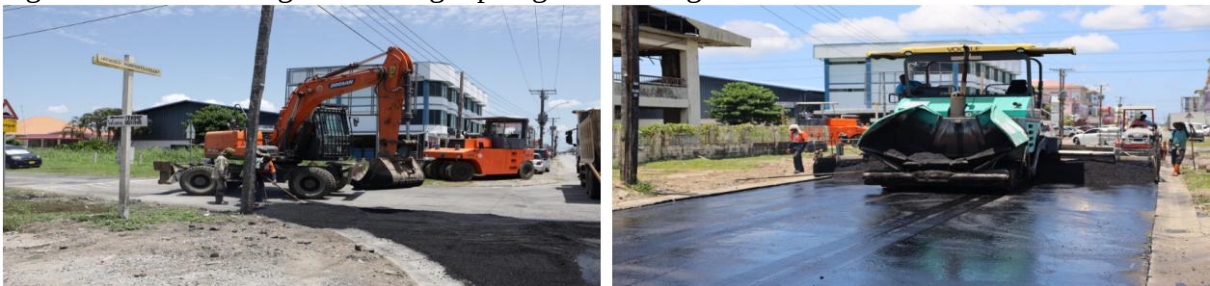
Figuur 14: Rehabilitatie werkzaamheden Jacques Gompertstraat in volle gang 2024.
