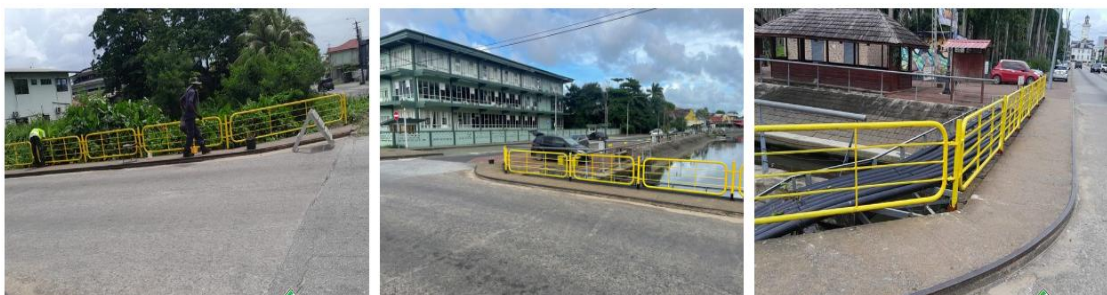
Figuur 17: Herstelwerkzaamheden brugleuningen brug Grote Combéweg over de Sommeldijkse kreek 2024.
