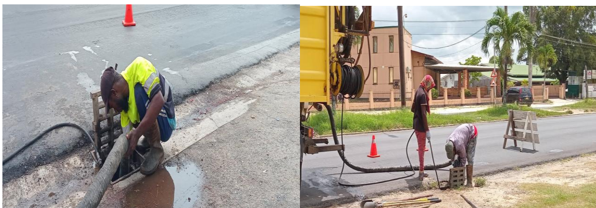
Figuur 97: Schoonmaak gesloten rioleringen binnen Paramaribo.
