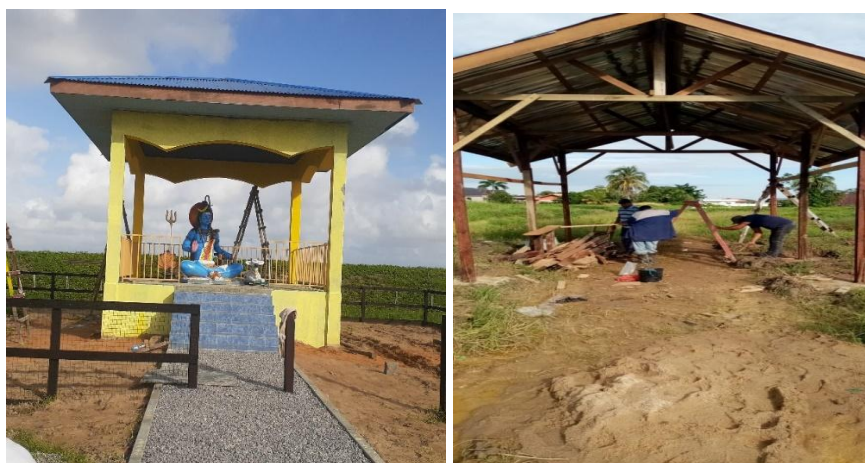
Figuur 68: Het bouwen van een kleine mandir bij Crematieoord en bouw van een afdakje bij begraafplaats te Hamptoncourtpolder.
