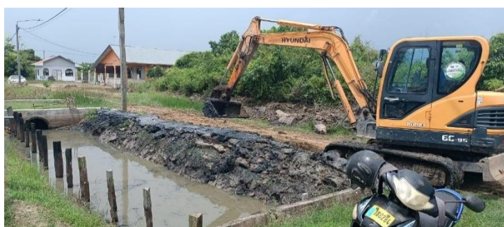
Figuur 69: Het uitdiepen van wegtrens in de Van Pettenpolder.
