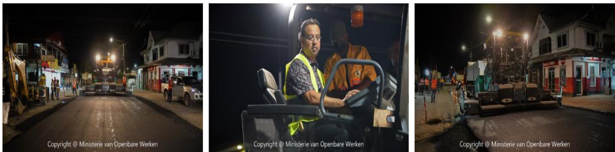
Figuur 13: Finalisering Asfaltering toplaag Kwattaweg 2024.
