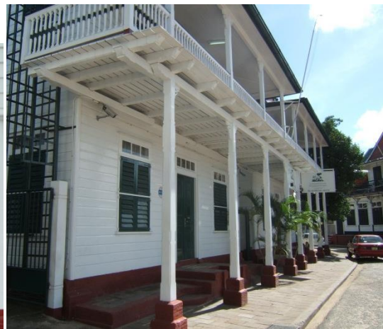
z.g. "ingebouwde" galerij. Dit is een oud galerijtype dat in de 18 e eeuw regelmatig werd toegepast
