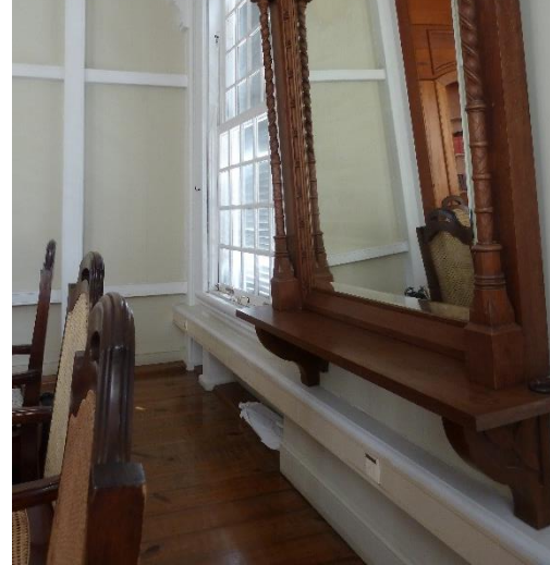
Horizontaal leidingkanaal onder kozijnen
