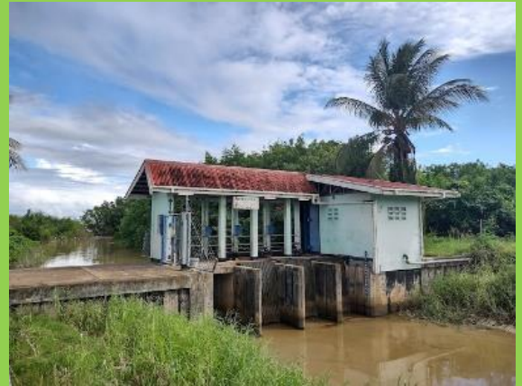
Foto 21: Pompgemaal Leonsberg (MOW-Nutsvoorziening & Beheer, 2024)
