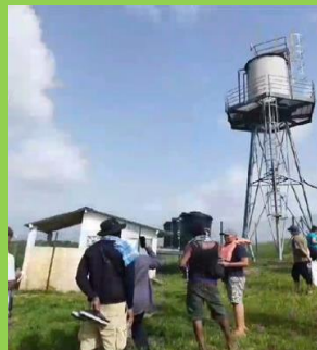
Foto 13: Bezoek waterleiding installatie te Grandsanti (MOW-WLA,2024)
