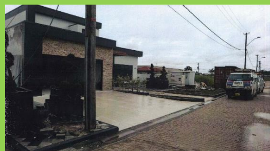
Foto 30: Werkzaamheden Uyinistraat (MOW-Nutsvoorziening & Beheer, 2024)
