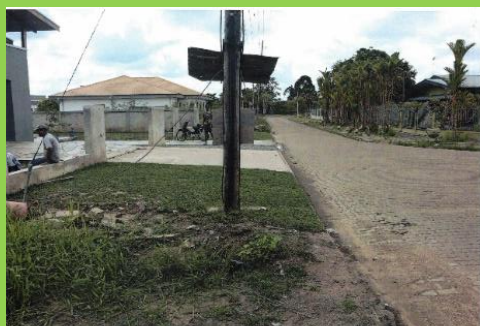
Foto 31: Werkzaamheden Kleidalaan (MOW-Nutsvoorziening & Beheer, 2024)
