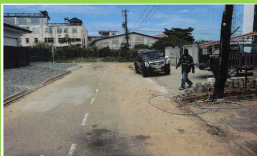
Foto 29: Werkzaamheden Gipssteenstraat (MOW-Nutsvoorziening & Beheer, 2024)
