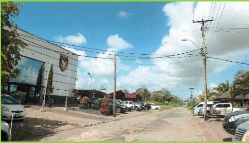
Foto 25: Werkzaamheden Bazaltstraat (MOW-Nutsvoorziening & Beheer, 2024)
