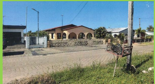
Foto 26: Werkzaamheden Carneoolstraat (MOW-Nutsvoorziening & Beheer, 2024)
