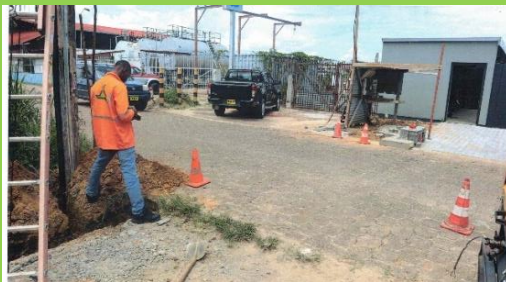
Foto 27: Werkzaamheden EBS, omgeving Doekhieweg Oost (MOW-Nutsvoorziening & Beheer, 2024)
