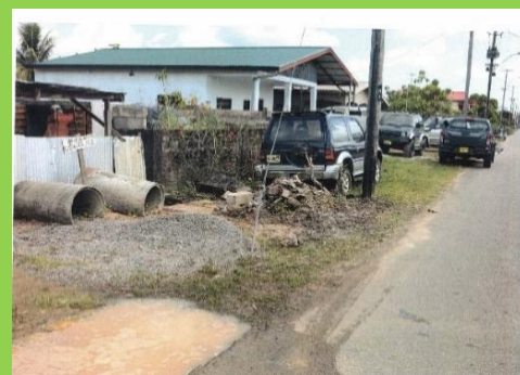
Foto 32: Werkzaamheden Naipalstraat (MOW-Nutsvoorziening & Beheer, 2024)
