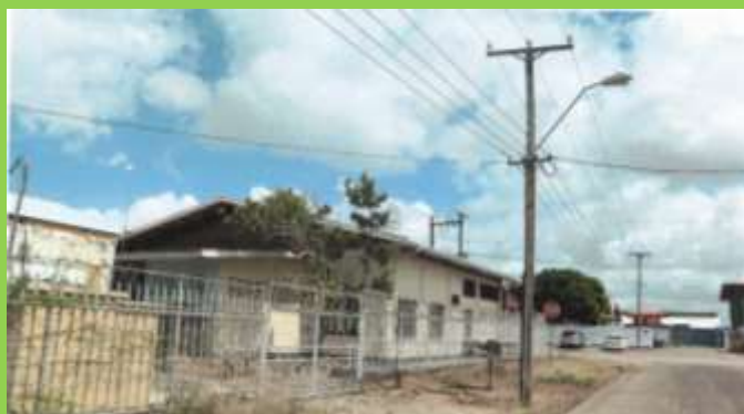
Foto 28: Werkzaamheden Omgeving Bonistraat (MOW-Nutsvoorziening en Beheer, 2024)
