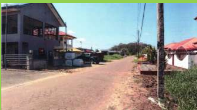
Foto 29: Werkzaamheden Thebestraat (MOW-Nutsvoorziening en Beheer, 2024)
