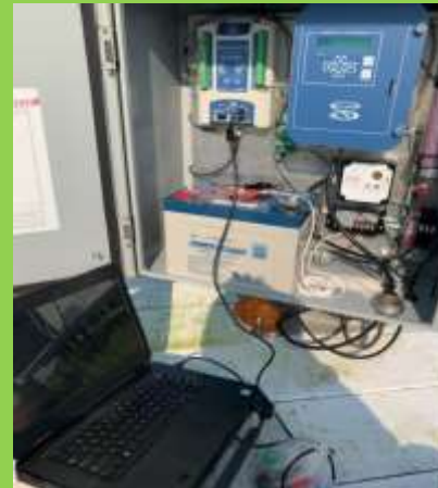
Foto 8: Data downloaden bij het Observatie station Nanni zwamp. Hier wordt zoals gewoonlijk gebruik gemaakt van een laptop (MOW-WLA, 2024)
