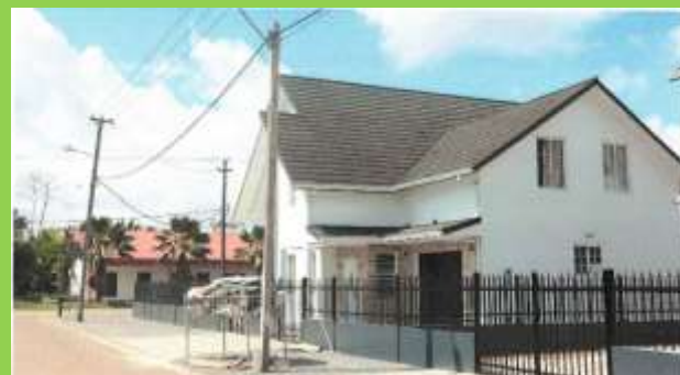
Foto 23: Werkzaamheden Bergamotstraat (MOW-Nutsvoorziening en Beheer, 2024)
