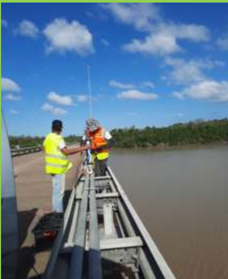
Foto 9: Coppename brug (MOW-WLA, 2024)
