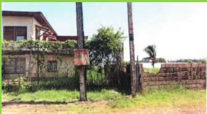
Foto 24: Werkzaamheden Bowlingstraat (MOW-Nutsvoorziening en Beheer, 2024)
