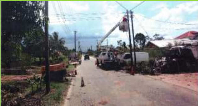
Foto 22: Werkzaamheden Trombonestraat (MOW-Nutsvoorziening en Beheer, 2024)
