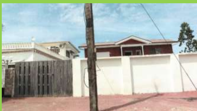
Foto 25: Werkzaamheden Goedhartstraat (MOW-Nutsvoorziening en Beheer, 2024)
