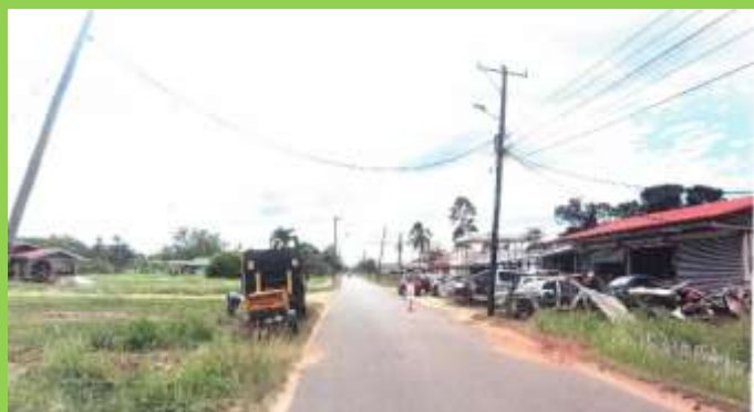
Foto 27: Werkzaamheden omgeving Helena Christina (MOW-Nutsvoorziening en Beheer, 2024)
