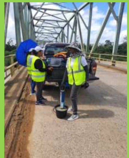
Foto 11: Saramacca brug (MOW-WLA, 2024)
