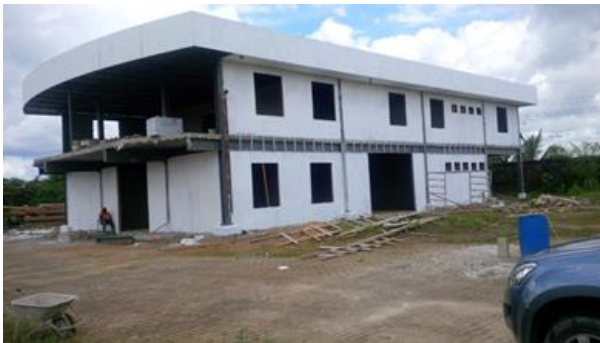
Niet afgeronde gebouwen van de Staat: Verkeersgebouw OW
