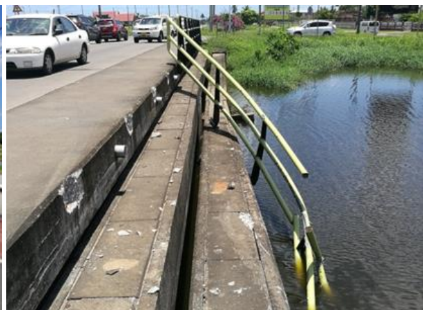
Herstelwerkzaamheden aan vele infra werken uitvoeren
