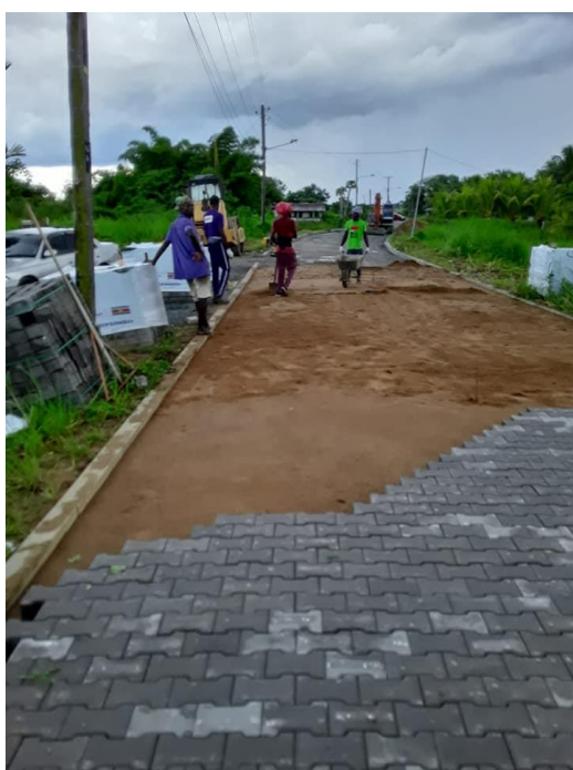
Het bestraten van de Alkmaarweg in het District Commewijne wordt gecontinueerd.
