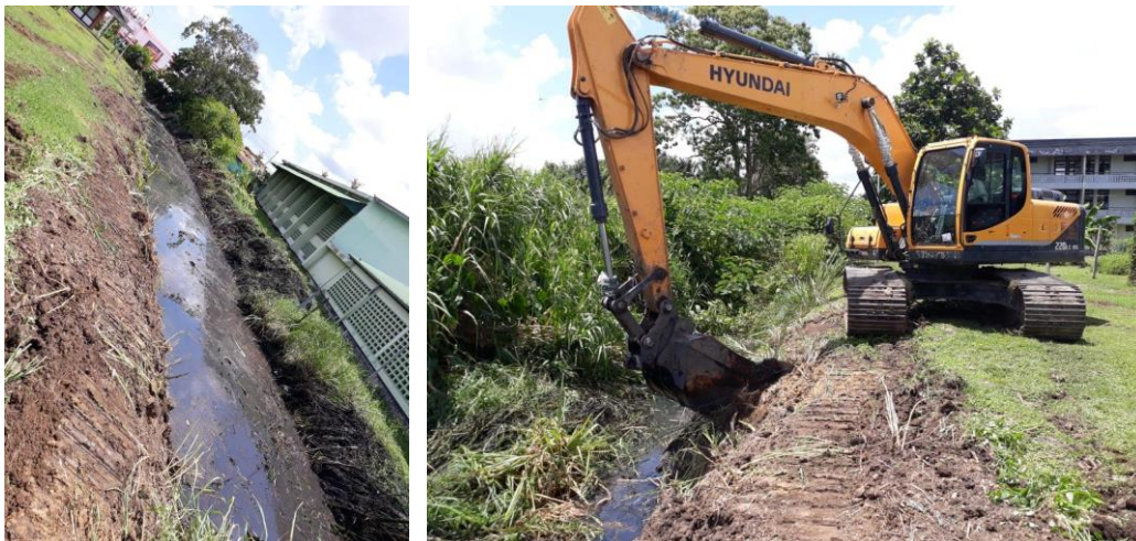
Onderhoudswerkzaamheden door OW, 2020
