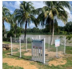
Foto 9: Hekwerk te Groningen waarvan de sensor nog geplaatst moet worden (MOW-WLA, 2023)
