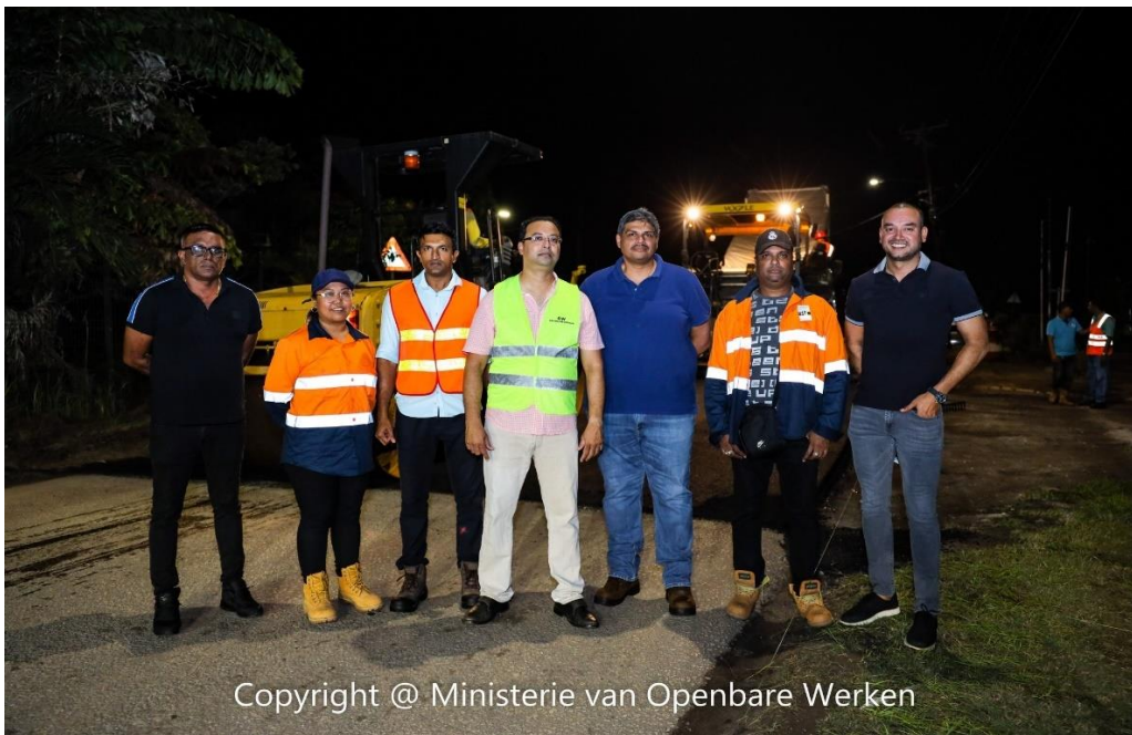
Herstel-en asfaltwerkzaamheden Kasabaholoweg
