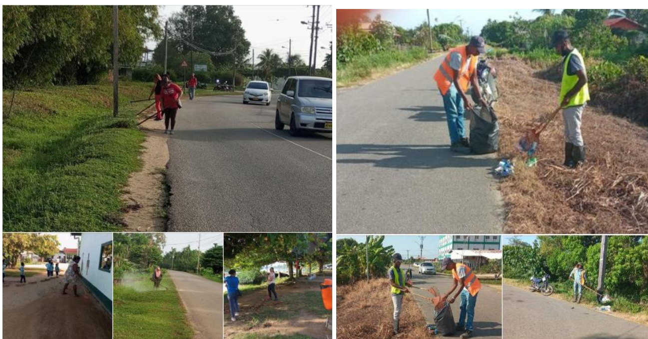
Onderhoudswerkzaamheden Groningen Saramacca en Opruimen zwervuul en petflessen uit de sloot
