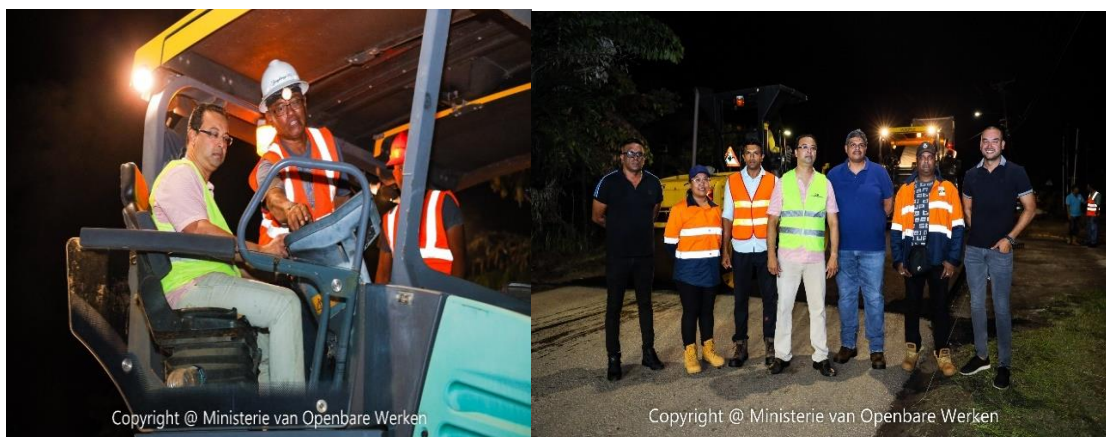
Figuur 12: Overzicht Asfalteringswerkzaamheden Kasabaholoweg
