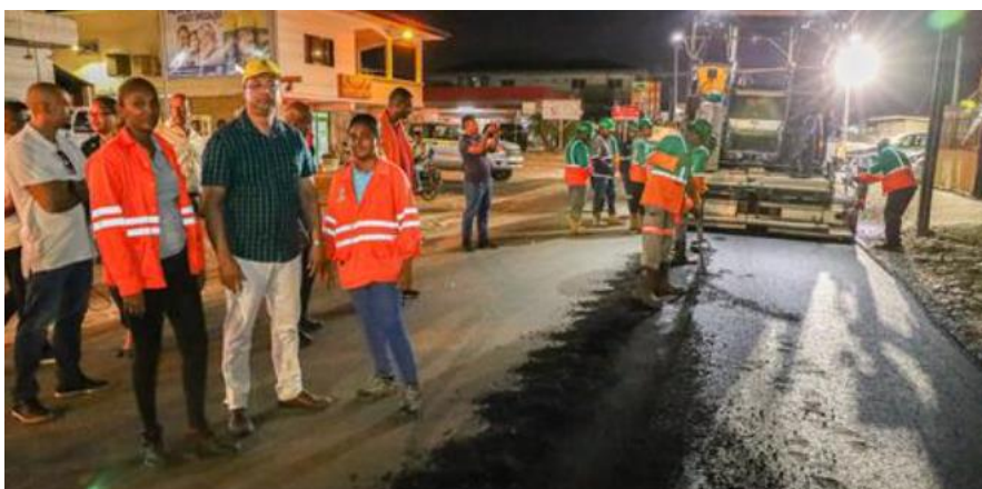
Asfalteringswerkzaamheden Kwattaweg en washingtonstraat
