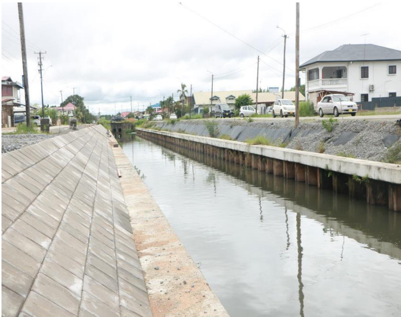
Damwanden en Taludbekleding Guaranistraat
