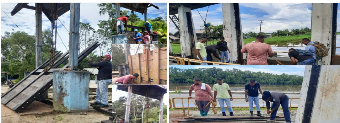
Figuur 22: Sluisdeur plantage Laarwijk Commewijne vervangen en reparatie sluisdeur Hazardsluis
