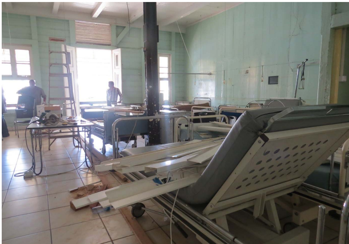
Foto: Renovatiewerkzaamheden in uitvoering Kamer 7 Interne op de 1 e etage in september 2018
