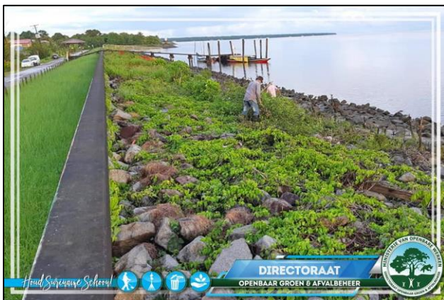
Figuur 6. 5 Onderhoud dijk te Nieuw-Amsterdam
