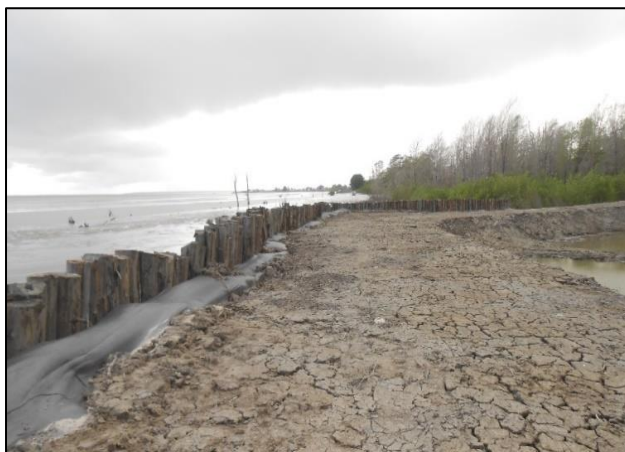
Figuur 5. 7 Aanleg kwelders te Weg naar Zee
