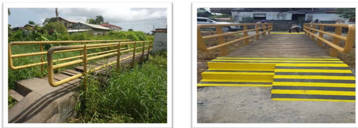
Figuur 5. 1 Renovatie houten brug te Oude Charlesburg (situatie voor en na)
