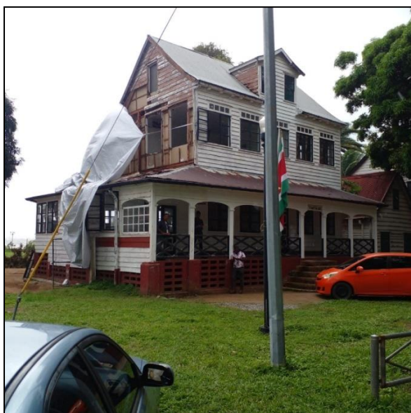
Figuur 4. 3 Renovatie gebouw Staatsraad
