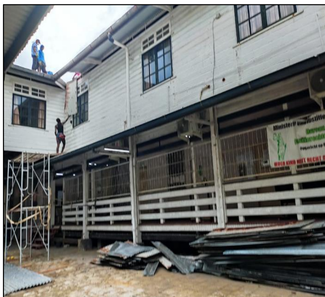
Figuur 4. 4 Renovatie gebouw Opa Doeli
