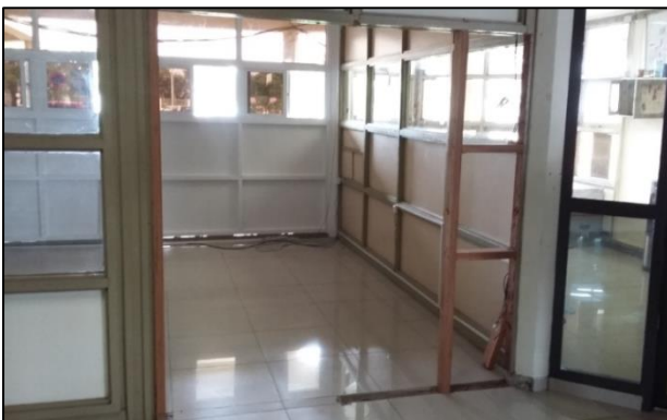
Figuur 3. 4 Renovatie kantoorruimte hoofdkantoor OW
