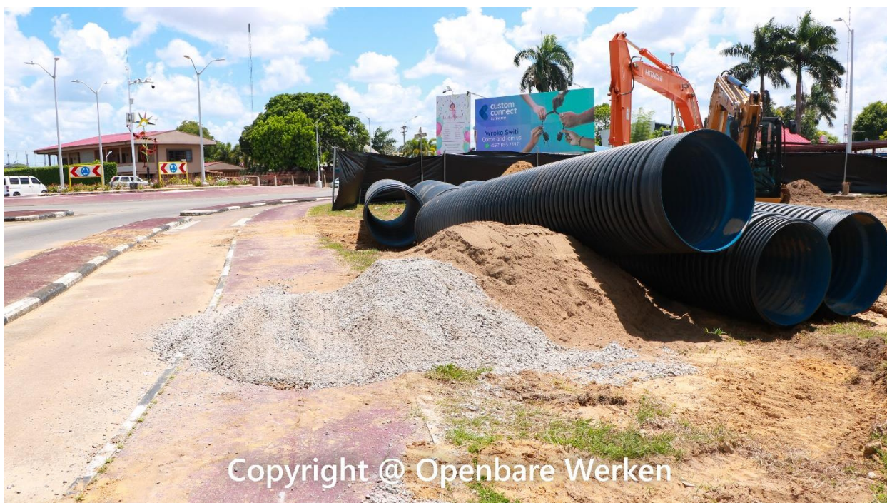
Rioleringswerkzaamheden Flustraet
