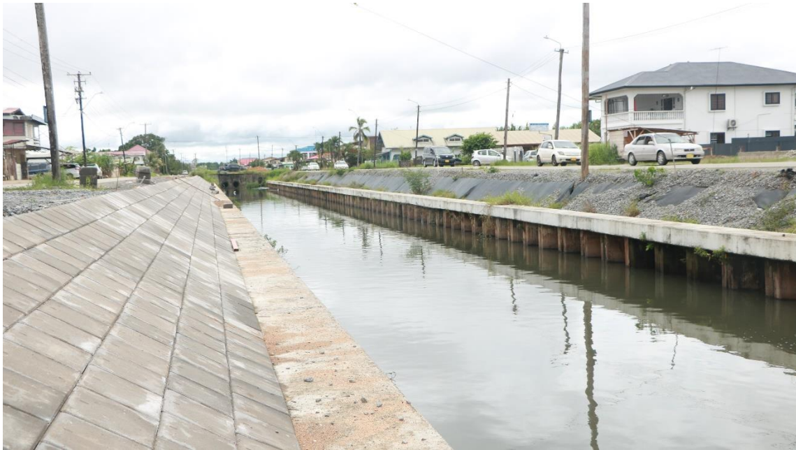
Damwanden en Taludbekleding Guaranistraat
