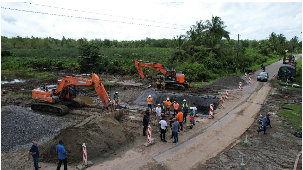
Rehabilitatie dwarsduiker Oost-West verbinding (Coronie)
