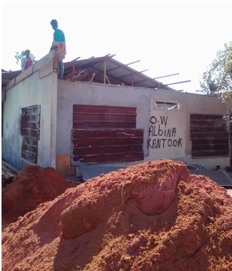
Renovatie OW kantoor te Albina
