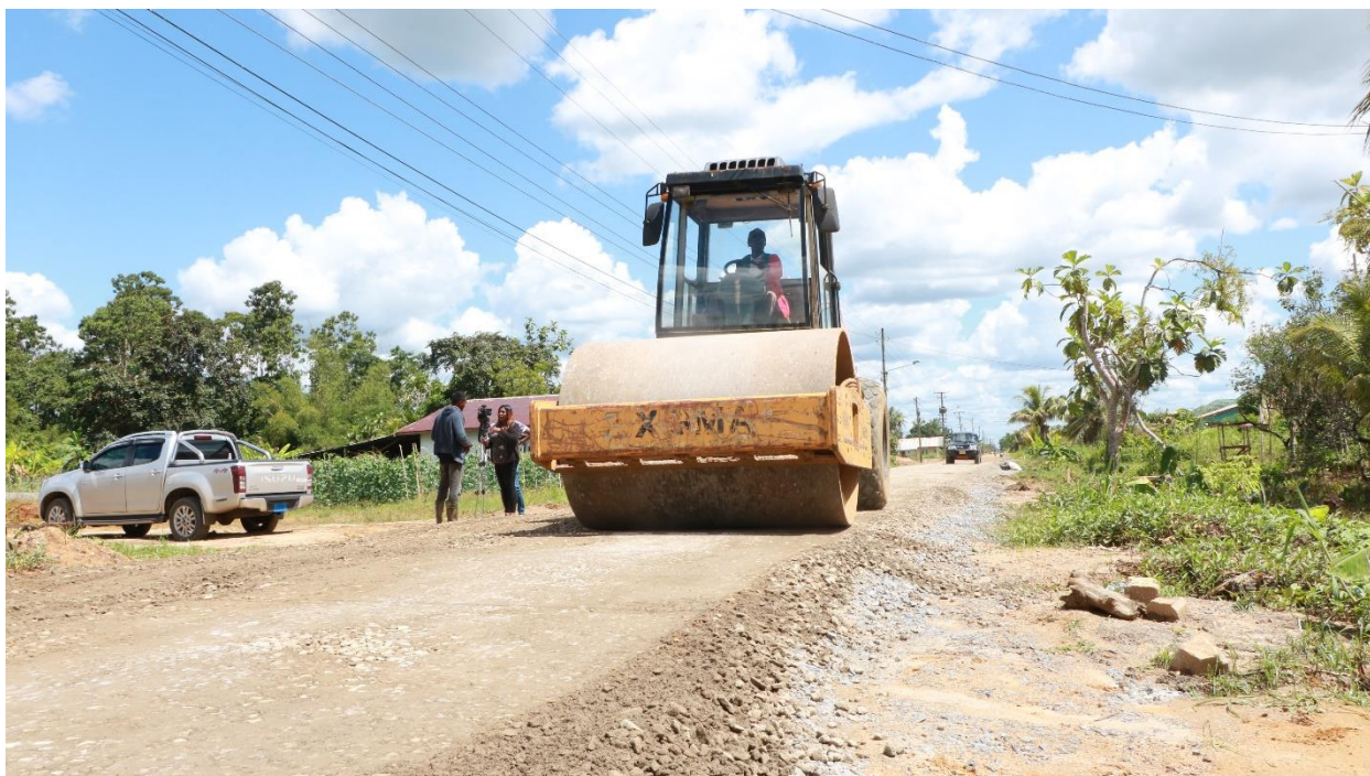
Bestratingswerkzaamheden Pt. Tilakdhariweg
