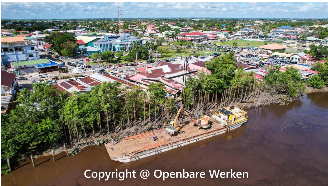
Beschoeiingswerkzaamheden achter markt nickerie reeds aangevangen
