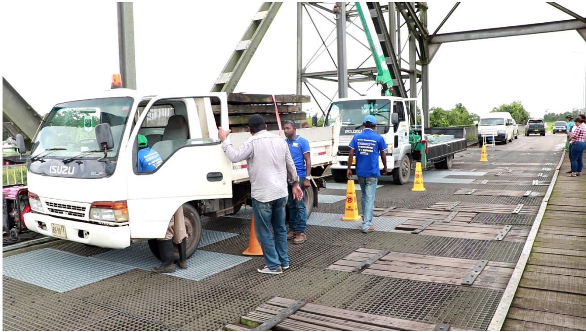
Vervanging stalen roosters Henarbrug
