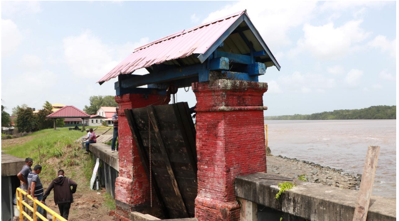
Vervanging sluisdeur Alkmaar
