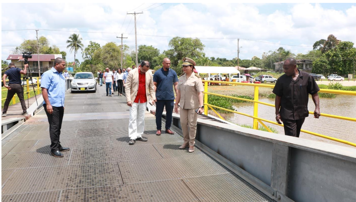
Reparatiewerkzaamheden aan de brug over het Wanicakanaal
