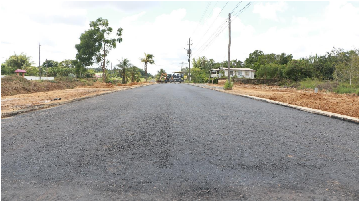
Asfalteringswerkzaamheden aan de Tout Lui Faut Kanaalweg
