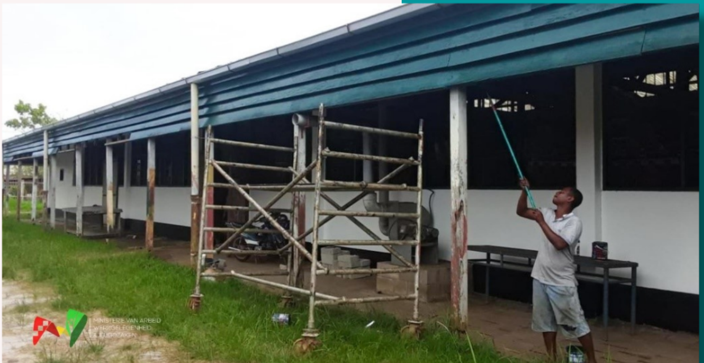
Een momentopname tijdens werkzaamheden bij de lasafdeling van SAO.
