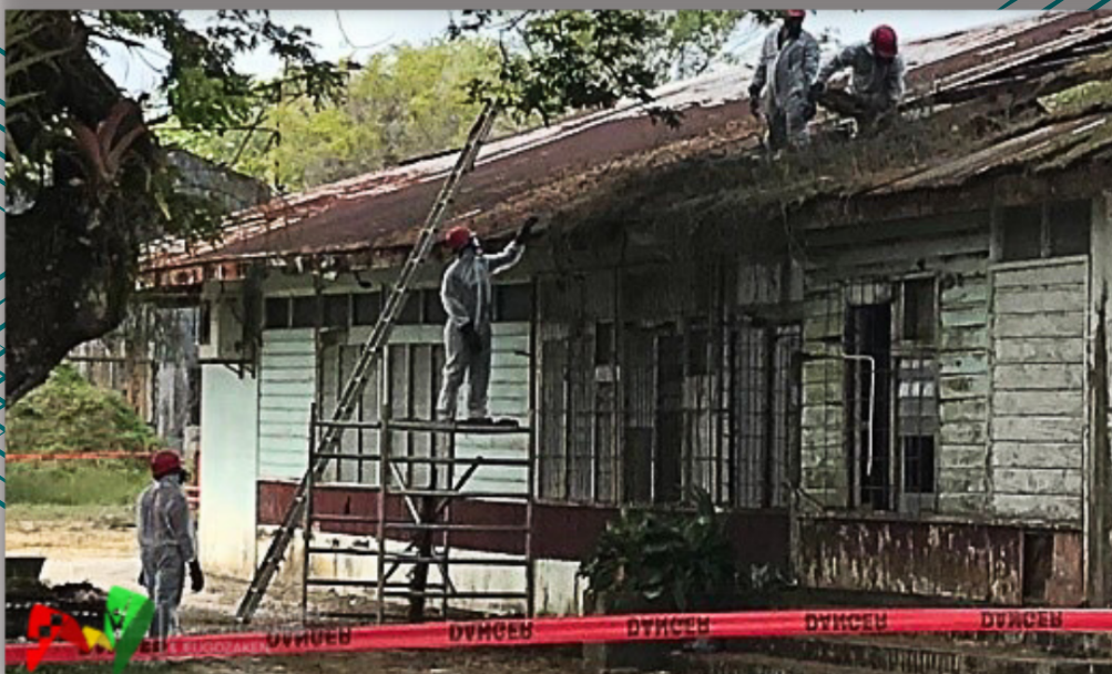
Aspirant-arbeidsinspecteurs worden bekendgemaakt met asbestsanering. Asbestontmanteling of asbestsanering moet worden gemeld bij de Arbeidsinspectie die streng daarop controleert.
