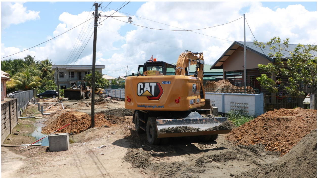
Riolering en wegfundering werkzaamheden aan de Bosche Reitzweg
