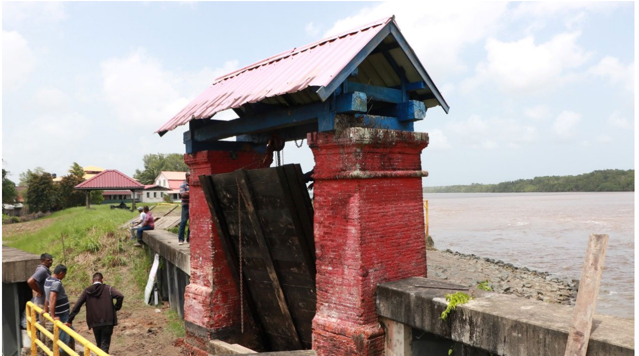
Vervanging sluisdeur Alkmaar
