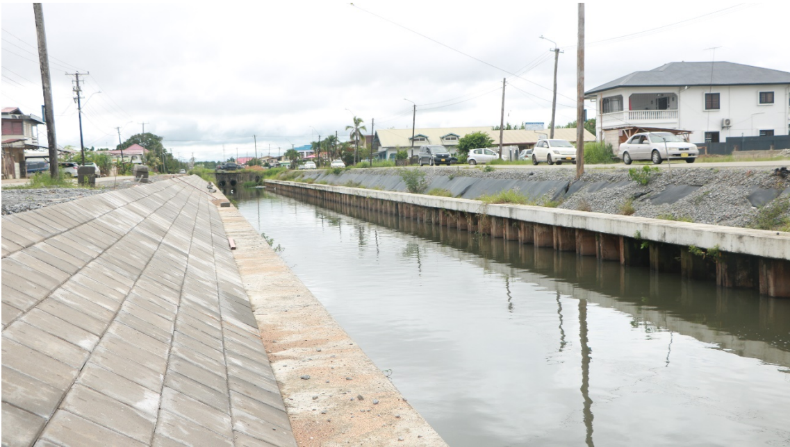
Damwanden en Taludbekleding Guaranistraat
