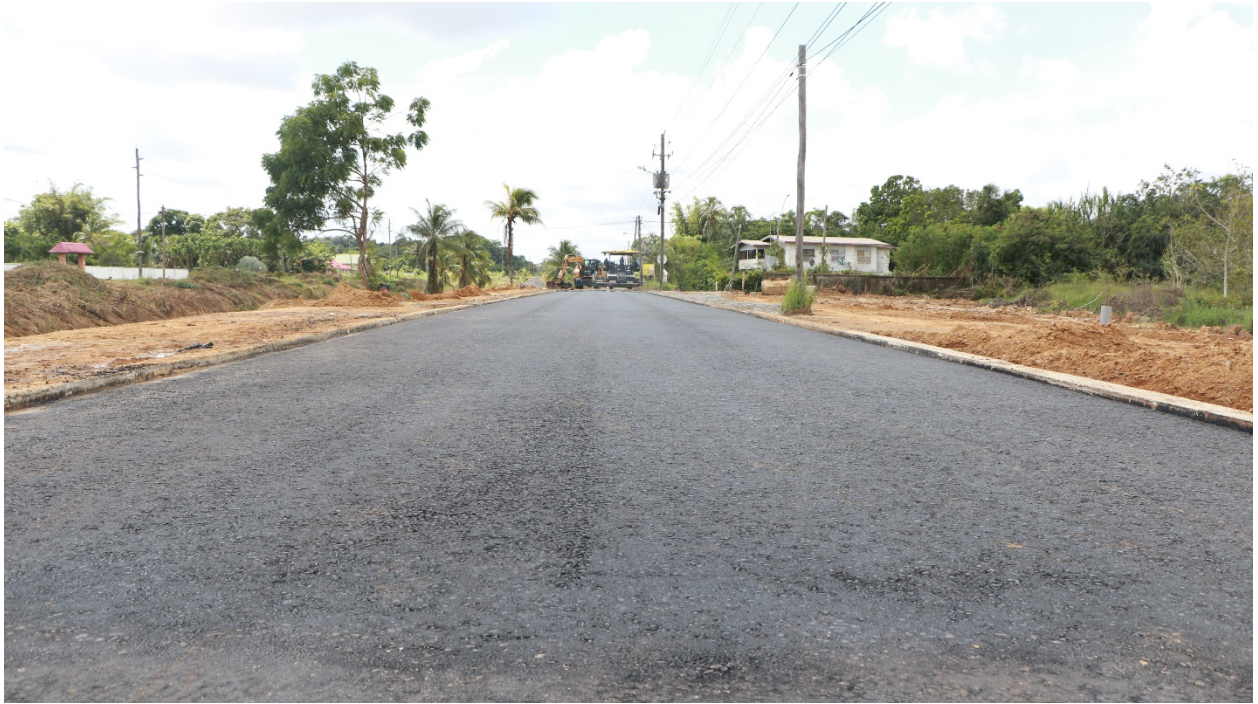
Asfalteringswerkzaamheden aan de Tout Lui Faut Kanaalweg
