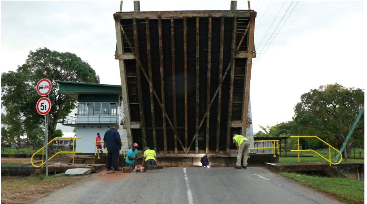
Reparatie werkzaamheden Ophaalbrug Uitkijk
