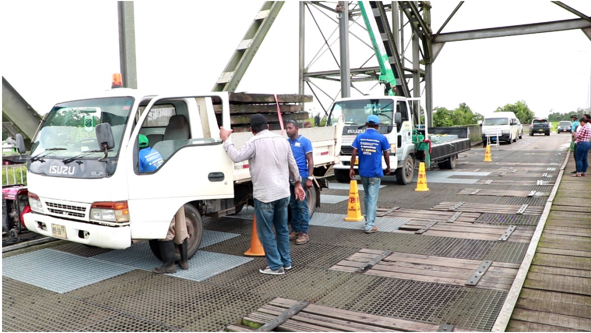
Vervanging stalen roosters Henarbrug
