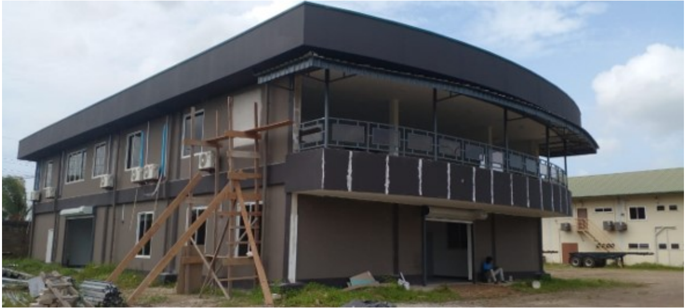
Het afbouwen van het gebouw van de afdeling Verkeer
