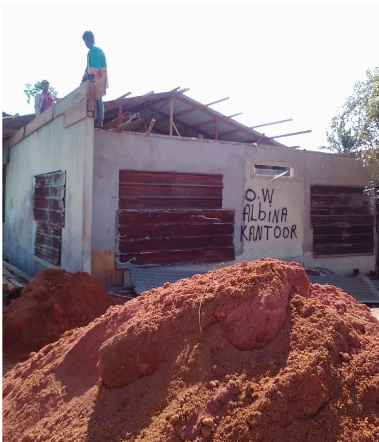
Renovatie OW kantoor te Albina
