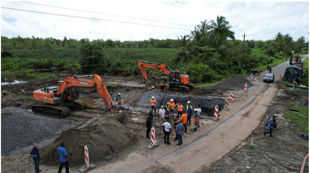
Rehabilitatie dwarsduiker Oost-West verbinding (Coronie)
