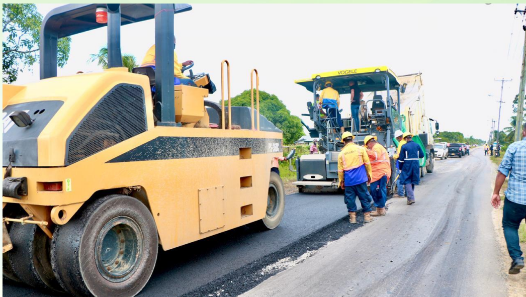
Foto: Herstelwerkzaamheden mr. P. Chandishawweg in volle gang
