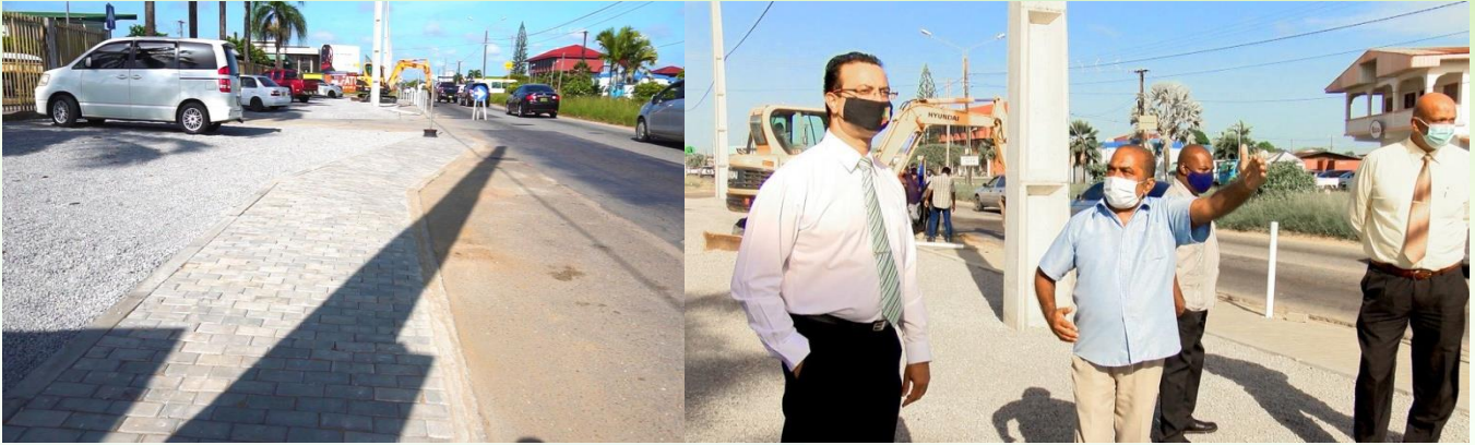
Foto:Indruk aanleg voetpad voor het hoofdkantoor van het ministerie van Openbare Werken
