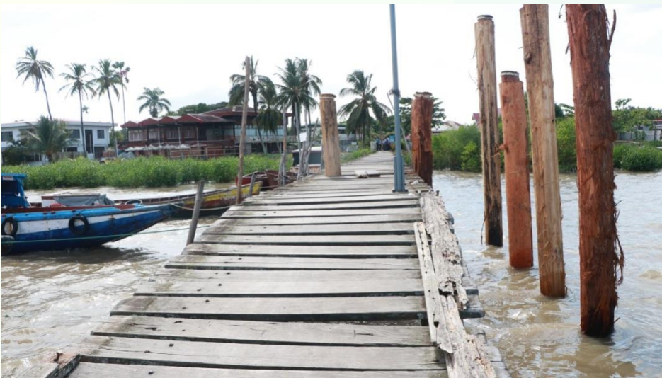
Foto: Aanvang rehabilitatie steigers Leonsberg, Platte Brug en Montresor.
