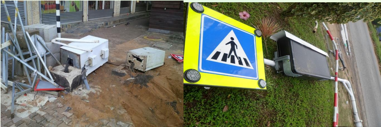
Foto: Vernietigde verkeersinstallatie
