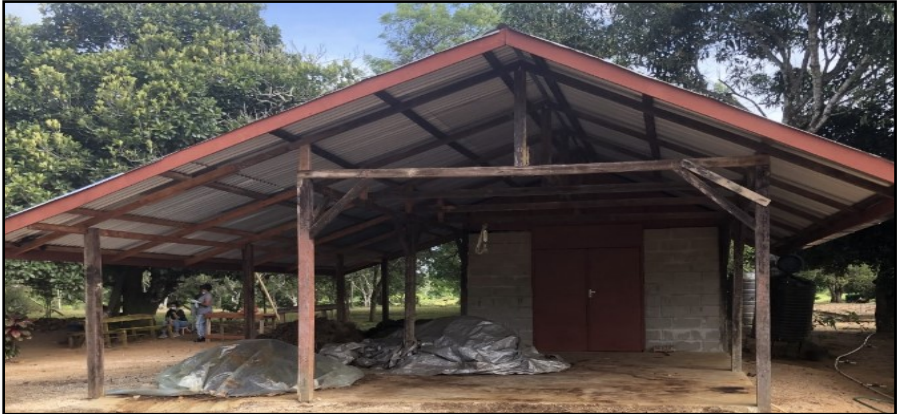
Foto 1: Compostkamp bestaande uit een verharde vloer, afdak en een opslagruimte.
