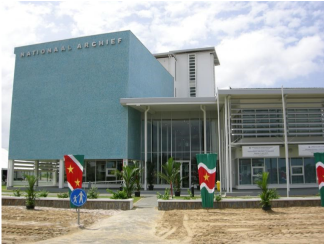
Het NAS-gebouw aan de Jaggernath Lachmonstraat.
