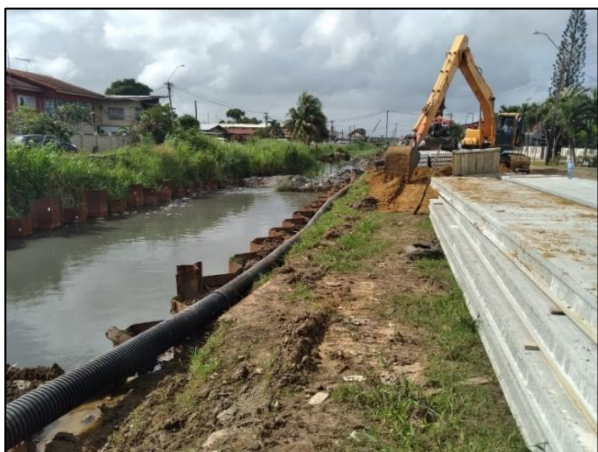
Figuur 5. 6 Taludbekleding te Guaranistraat
